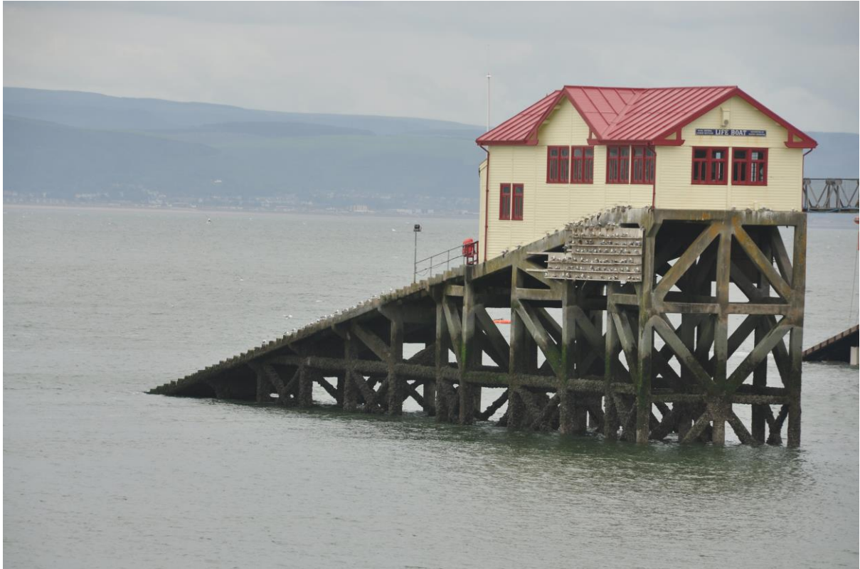
a. Mumbles Pier
