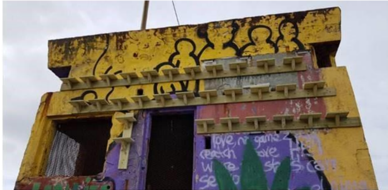
På sørjeteen (Folk i Tromsø kaller molo for jete) har forskerne bygd alternative reirplasser. Nå gjenstår det å se om krykkja flytter inn. Foto: Tone Kristin Reiertsen.
